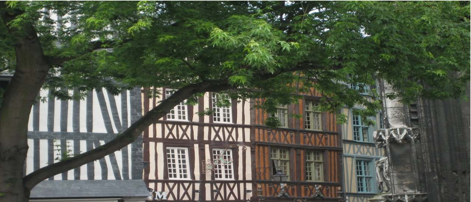
Exemple d'une maison normande à colombages
