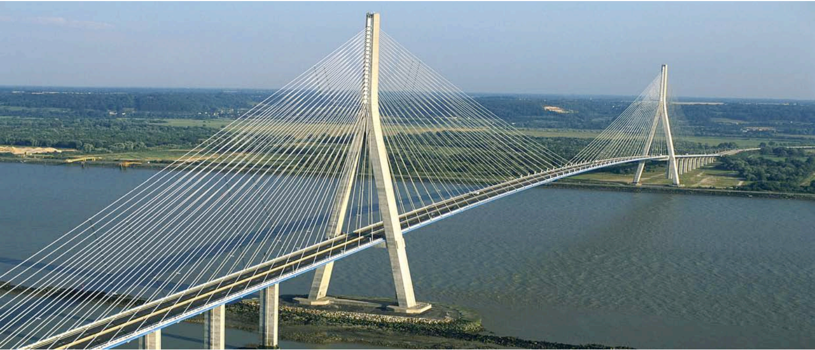
Le pont de Normandie
